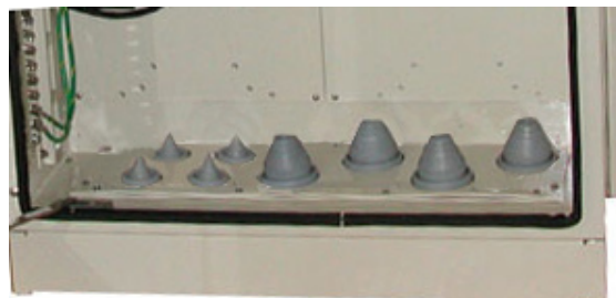
Fig. 4-1, Conduit Seal Location
